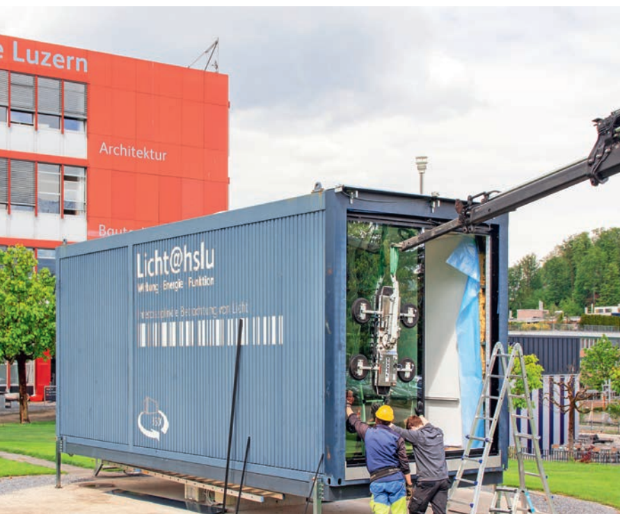
Der Lichtmesscontainer auf dem HSLU-Campus in Horw beim Einbau der elektrochromen Verglasung.
