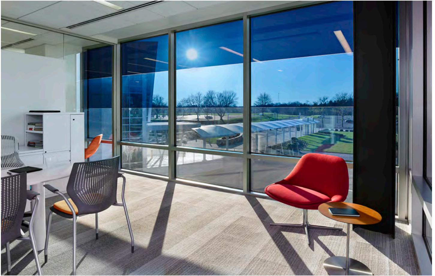
Beispiel einer Verglasung, die vertikal in drei Zonen unterteilt ist, deren Verdunklung sich einzeln regeln lässt. Foto: SageGlass/Jeffrey Totaro
