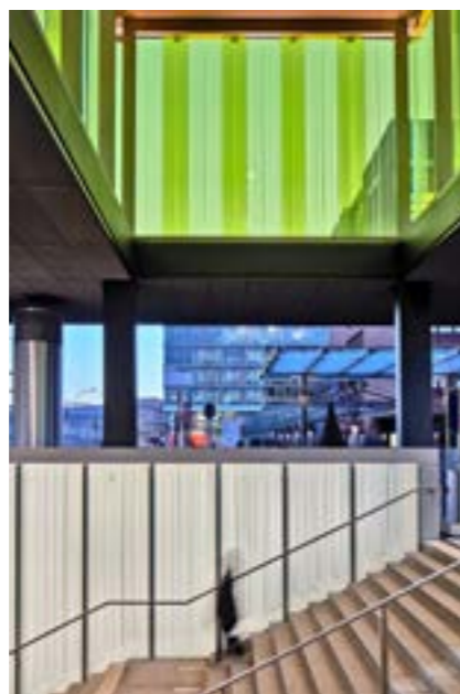
Die Gestaltung der Oberlichtlaterne durch Vogt-partner beim Bahnhof Oerlikon wird in der leitenden Lichtwand weitergeführt.
