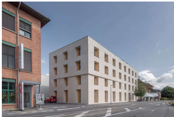
Relativ kleine Fenster, dicke Mauern: Das helle Gebäude an der Emmenweidstrasse gilt als gutes Beispiel für klimagerechtes Bauen.
