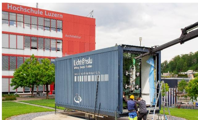
Abbildung 3 – SageGlass Harmony™ Einbau in den LichtMessContainer in Horw [Quelle: Licht@hslu]
