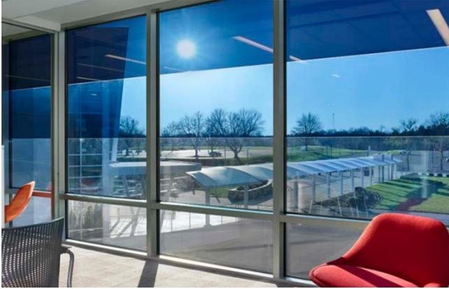
Abbildung 1 – Beispiel eines Dreifacheilung der Glasfläche mit durchsichtiger Brüstung [1, S. 4]
