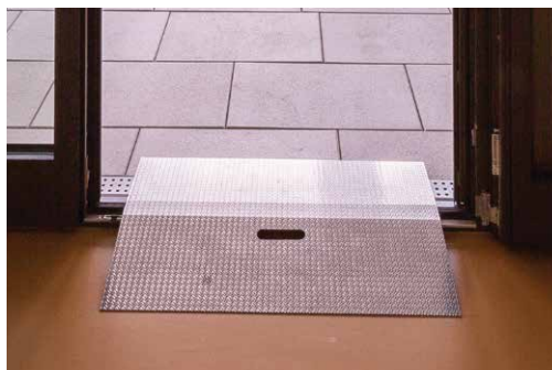
Abbildung 49: Metallrampe bei Zugängen [Quelle: Licht@hslu]
