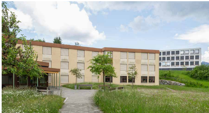
Abbildung 1: Altes Pflegezentrum im Vordergrund, dahinter der Neubau [Quelle: Licht@hslu]
