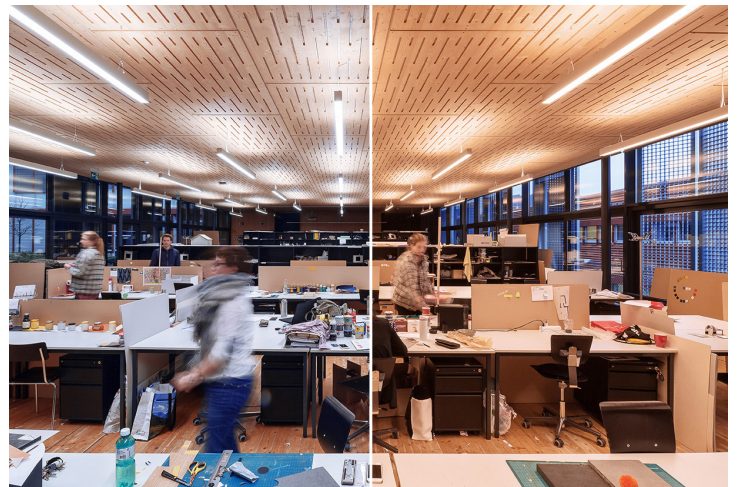
HCL-Testanlage in Kooperation mit Moos Licht AG und Tridonic AG auf dem Campus in Horw. Bild links: Kaltweiss 6500K, Bild rechts: Warmweiss: 2700K
