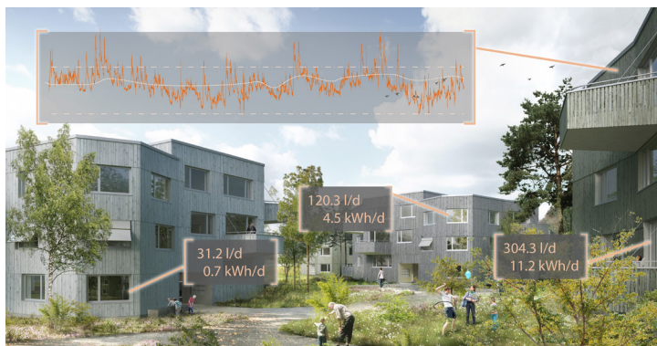
Überbauung Hüttengraben, Küssnacht
