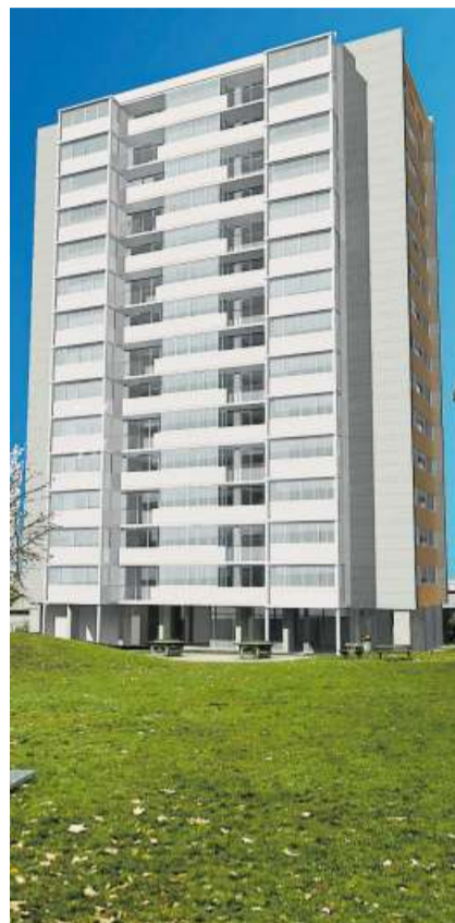
Ein Hochhaus in Bern ist bis jetzt das einzige Referenzobjekt.
