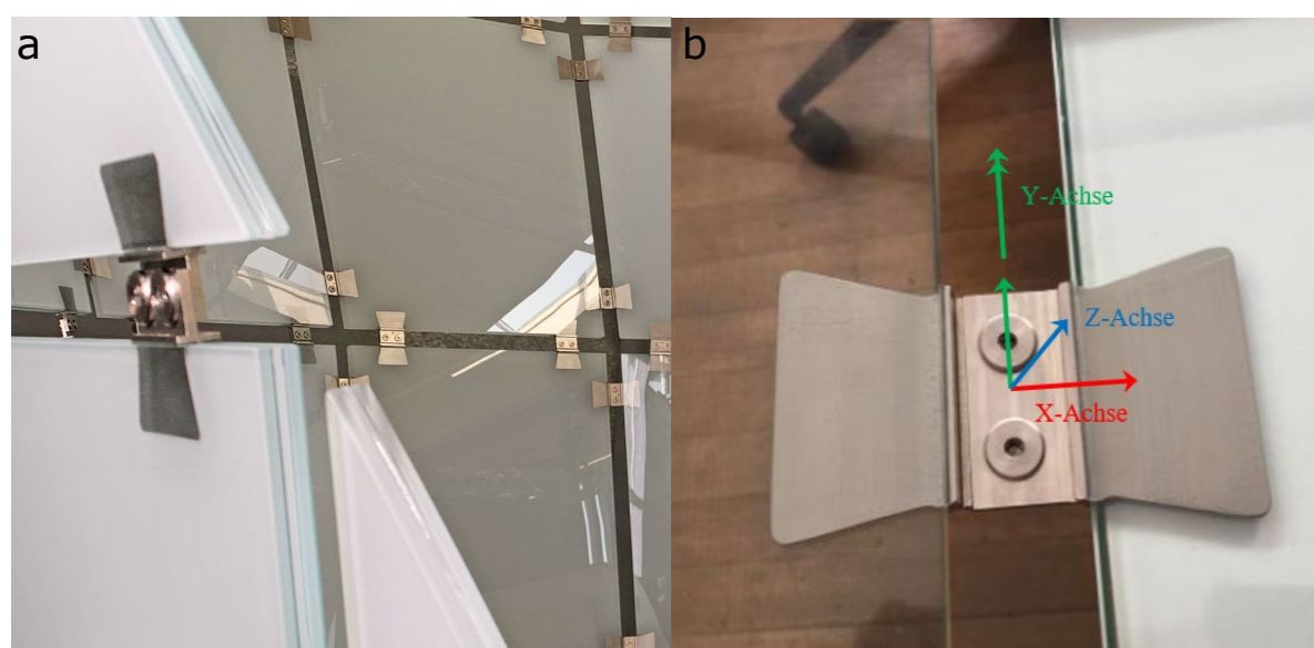
Bild 2: a: In der Schale verbauter Fitting b: Wirkungsachsen der Steifigkeiten (Quelle Bild a: Fildhuth et al., 2022; Quelle Bild b: Fildhuth, 2020; siehe Literaturverzeichnis der These, Seite 63)
