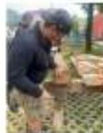
Im nächsten Schritt wird das Holz mit dem Loch aus der Erde entfernt, damit die Holzattung eingesetzt werden kann.
