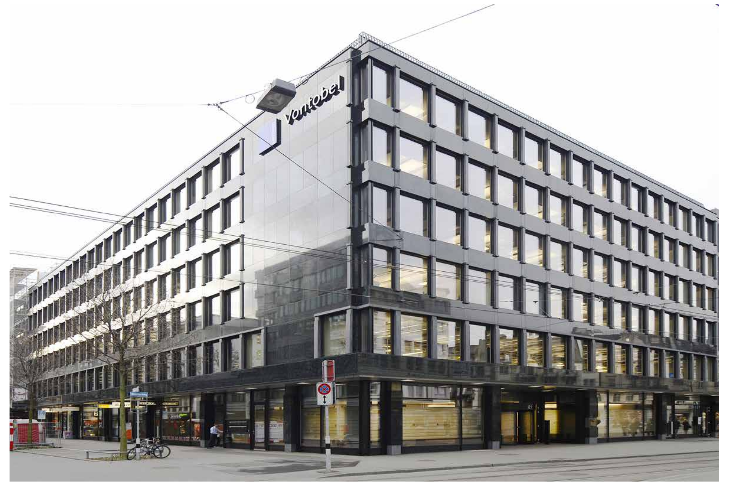
Sanierung 2012-13 „Das Studio Märki wollte das Gebäude „erden“ und entschied sich neu eine vertikale Wirkung zu erzeugen. (Elemente zwischen Fenster)“ „Wärmetechnische Sanierung“ „Das Ganze Gebäude entlang der Strasse als Einheit in Materialität und Erscheinung (auch Altstockgeschoss)“ „Naturstein-Granit-Labrador vom Bestand übernommen, gereinigt und wiedermontiert“ „Türlungen und Massentüren nach bestimmten Regeln (ausgehend vom Hauptachsmass)“ „Mezzaningeschoss Neu interpretiert“
