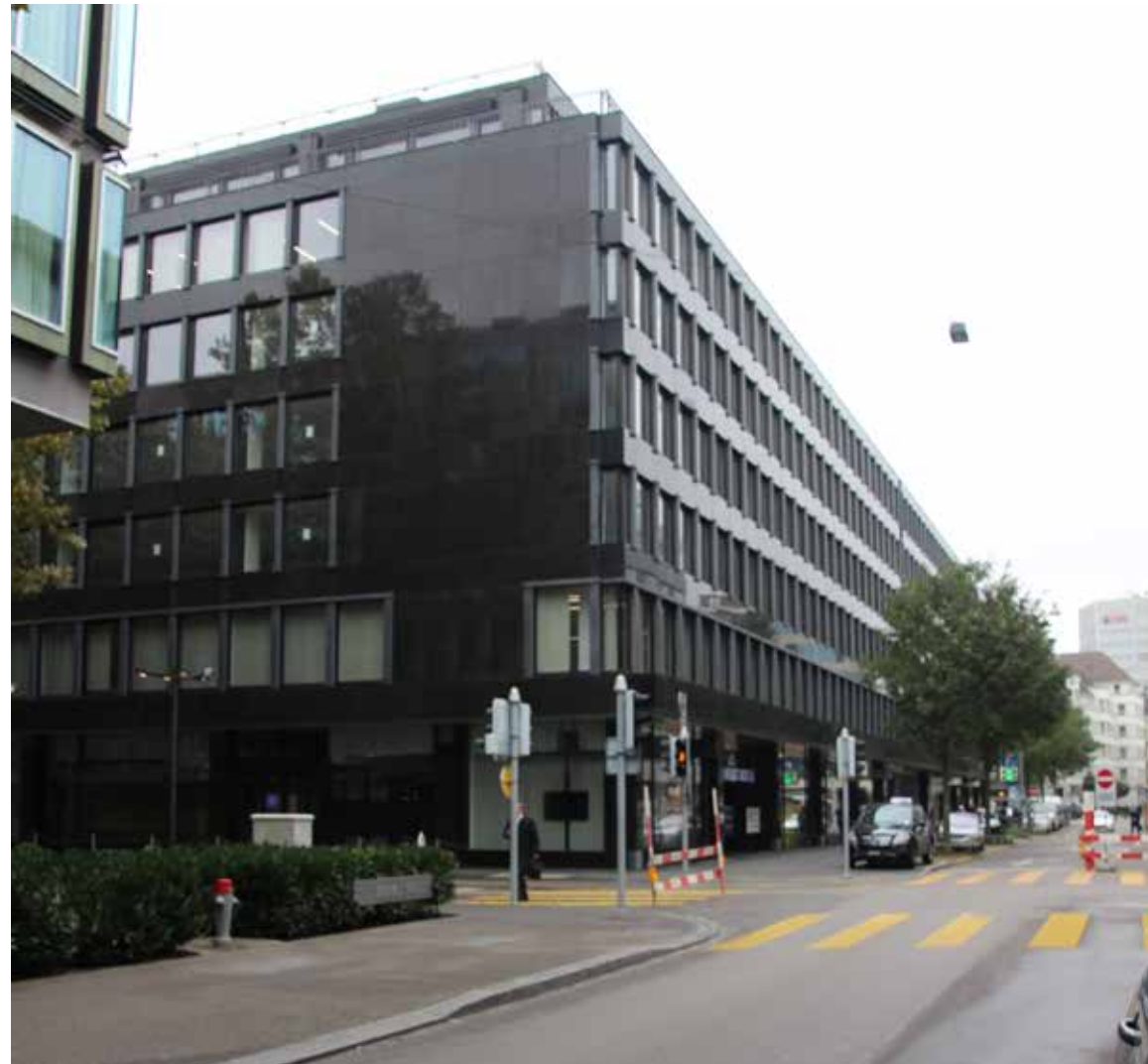
Umbau Nachbargebäude zur Zeit in Bauphase. Ausführung erfolgte wie Blockweg 21 ebenfalls von Studio Märki
