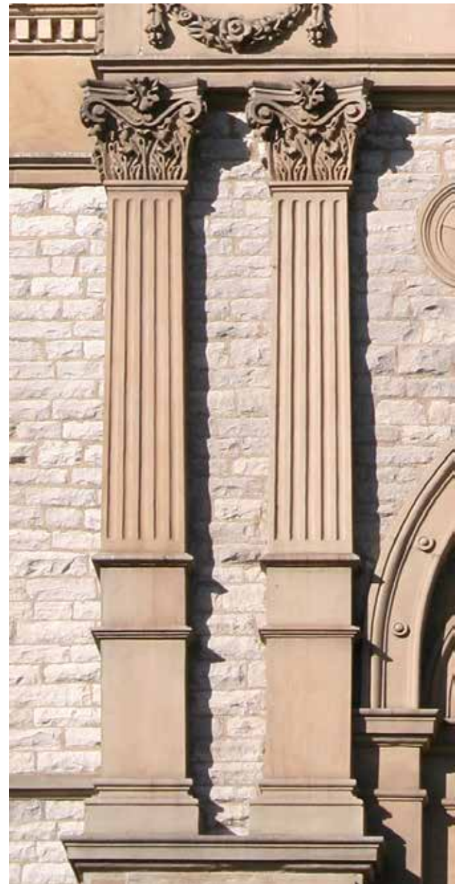
Interpretation eines Pilasters in heutige Bauten. Sichtbar vertikale Elemente zwischen den Fenstern.
