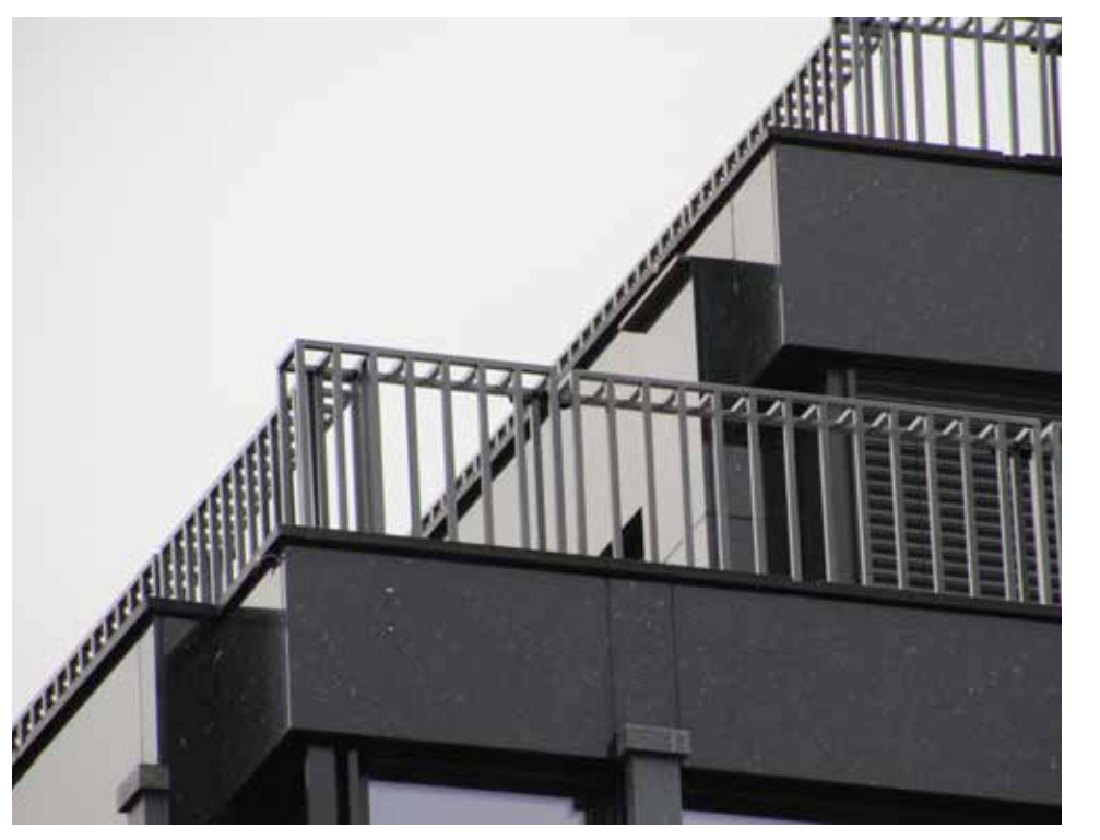
Attika-Geländer - prägnant ausgebildet
