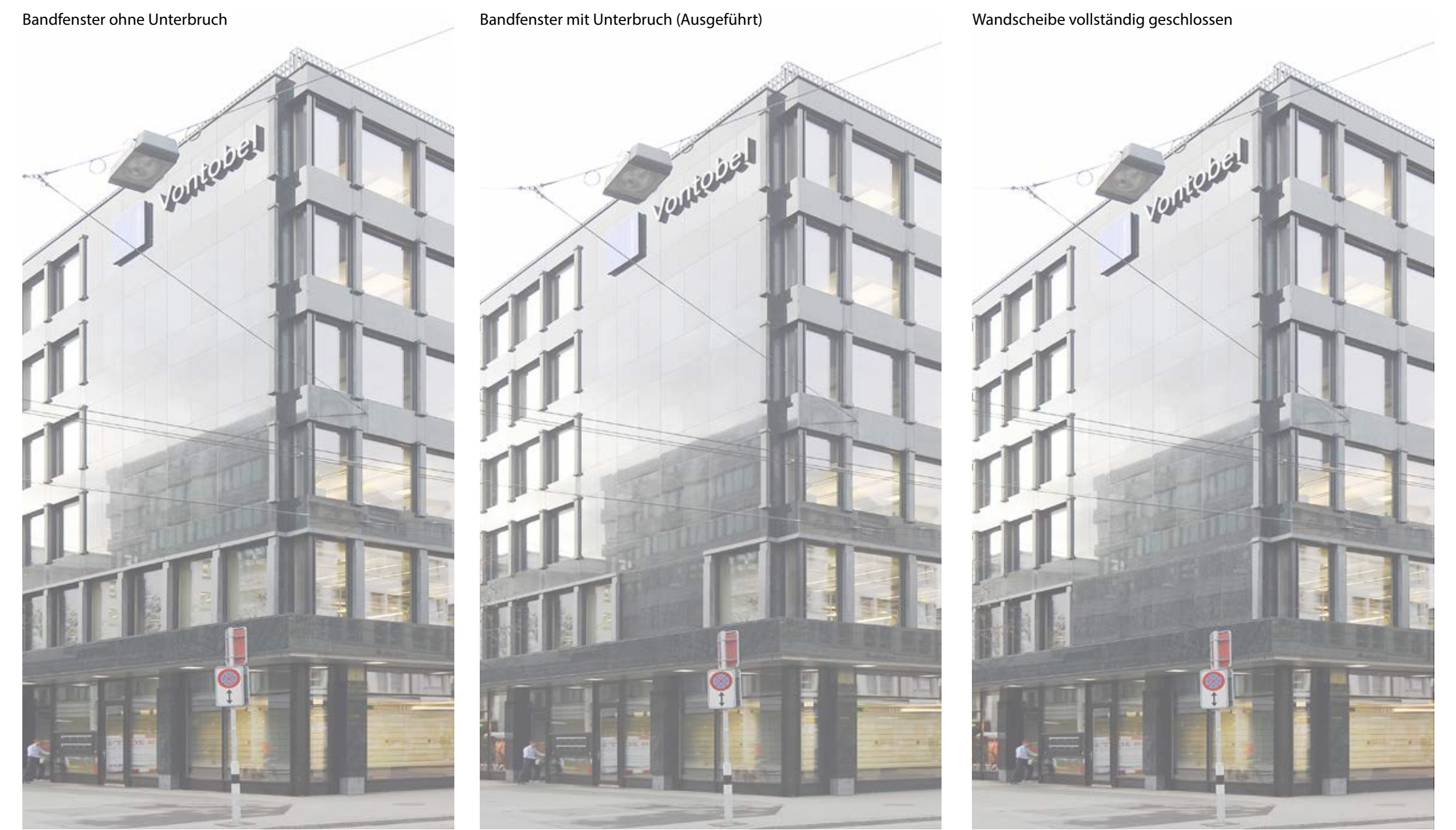
Untersuchung Wandscheibe vs. Bandfenster Die ausgeführte Variante unterscheidet sich entscheidend in der Wahrnehmung des Mezzaningeschosses. Die Rahmung des Fensterbandes und die zusätzlichen Fensterflächen verstärken die Wichtigkeit.
