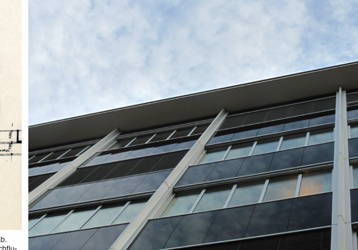
Die Bandenleiter verlaufen in der äussersten Schicht, so wird die Tragstruktur im Innern durch die weissen, vertikalen Elemente nach aussen getragen. Die äussere Bekleidung des Gebäudes ist wesentlich neuer als die Tragstruktur im Innern.
