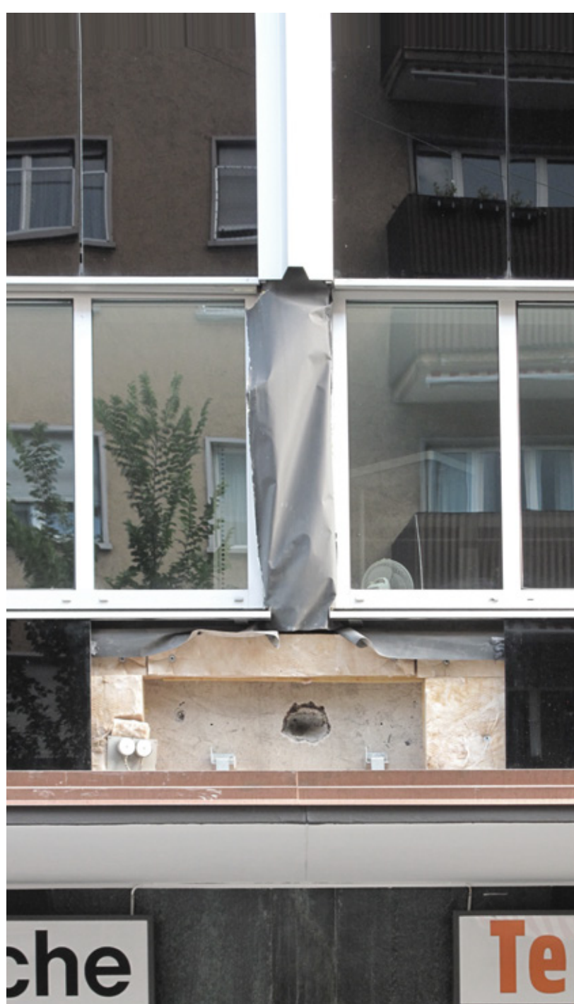
Die Bauteile in der Fassade lässt die Konstruktion erahnen, zeigt jedoch dass die Platten in der Ordnung der Strassenfassade mehr Schein als Sein sind. Die Tragstruktur des Gebäudes befindet sich weiter hinten in der Schicht der Fassade, zeichnet sich auf diese Weise jedoch in der Fassade ab.
