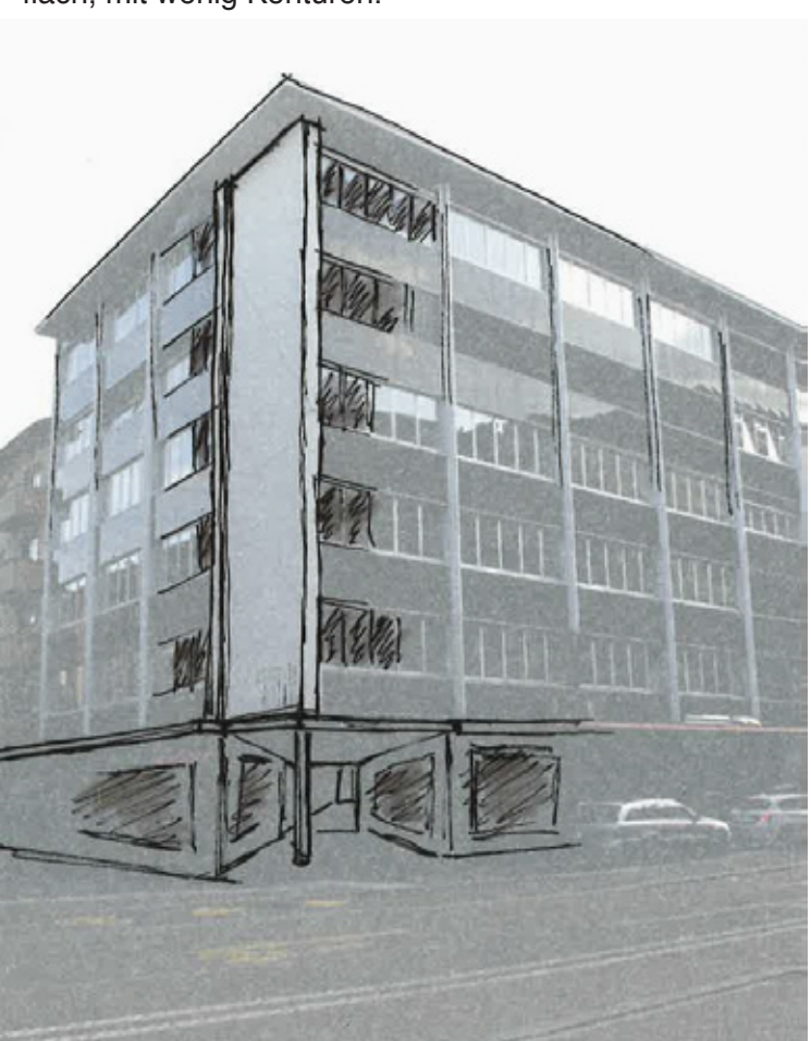
Die „Eck-Studie“ zeigt wie Burzi die Ecke des Gebäudes festigt und auf die Kreuzung reagiert. Die umliegenden Gebäude greifen ebenfalls dieses Thema auf, interpretieren jedoch die Ecke unterschiedlich. Die Wandscheibe als Abschluss in der Ecke, einerseits ein statisches Element, aber eben auch um die Ecke zu markieren, respektive auf die Kreuzung architektonisch zu reagieren.
