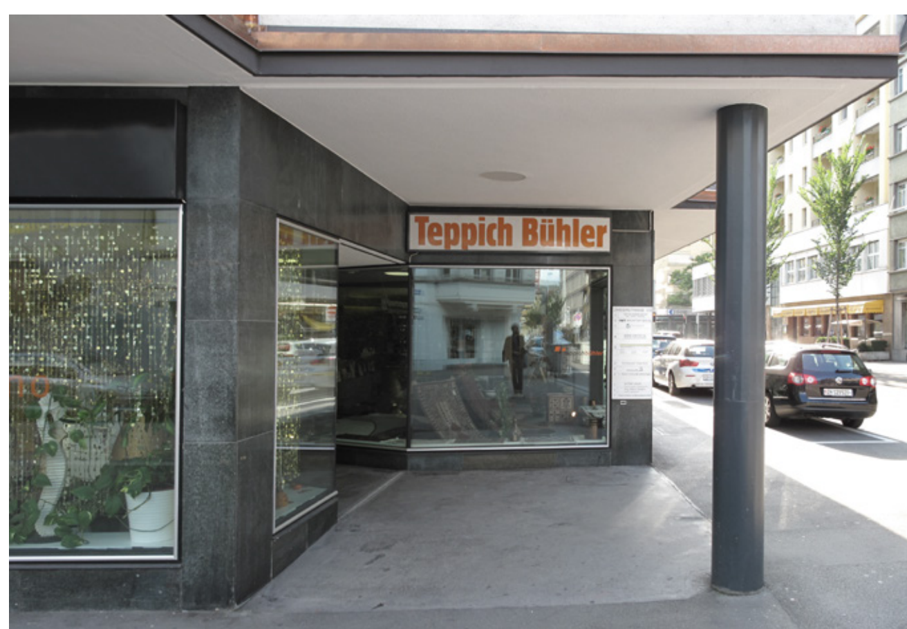
Der Eingang im Erdgeschoss wird in der Ecke durch einen Ausschnitt im Volumen markiert. Mit der runden Stütze wird die Auskragung des Gebäudes abgefangen. Durch den Ausschnitt entsteht ein kleiner Vorbereich, der den Besucher vor dem Eintreten in den Erschliessungsgang abtut.
