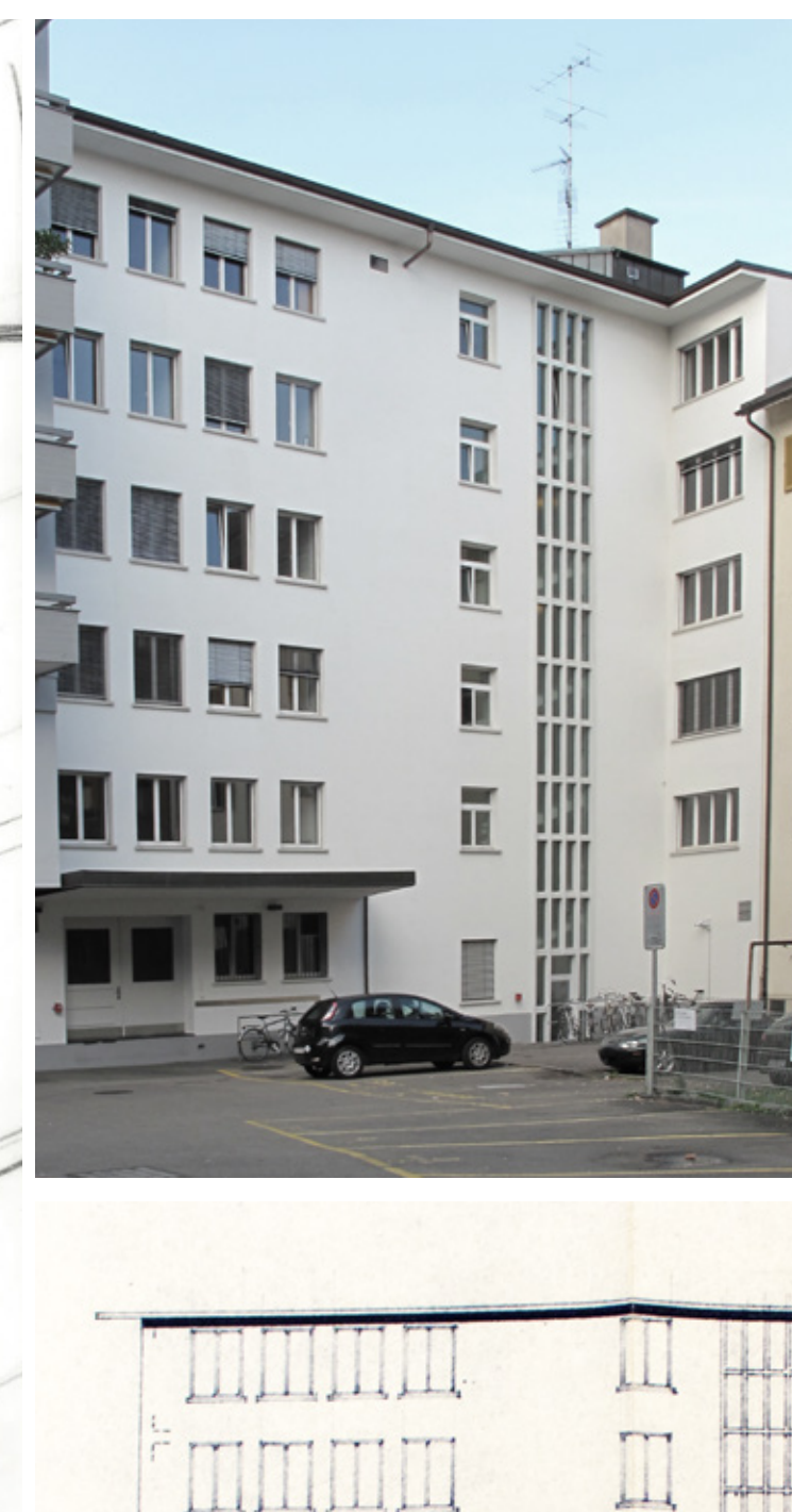
Erste Versuche den Aufbau der Konstruktion und der unterschiedlichen Schichten herauszufinden. Der Ausdruck und das Bauglied lassen erahnen, dass eine gewisse Ähnlichkeit zum Möbelgenossenschaft-Geschäftshaus von Hans Fischli in Basel besteht.
